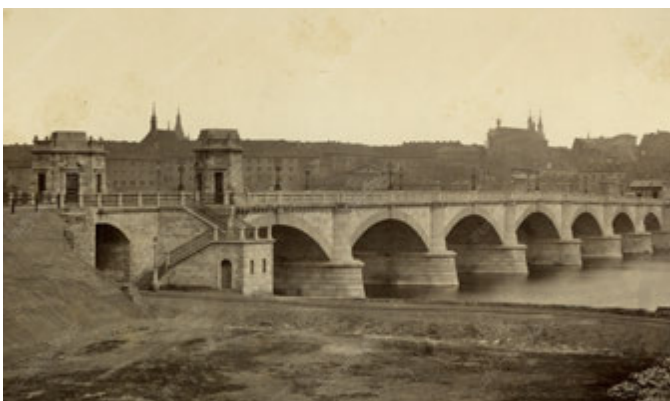
Palackého most po dokončení, zatím bez soch; foto: K. Maloch, 1878; MMP, inv. č. 000398-001; výřez
