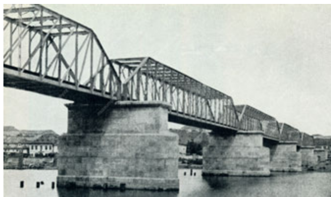
Původní železniční most z roku 1872; foto F. Fridrich; výřez
